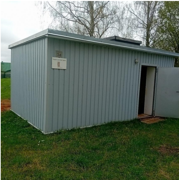
Joonis 5-5 Puka Ääre tn pumplahoone välisilme
