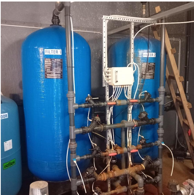
Joonis 5-10 Sangaste pumplahoone sisevaade, paralleelsed survefiltrid
