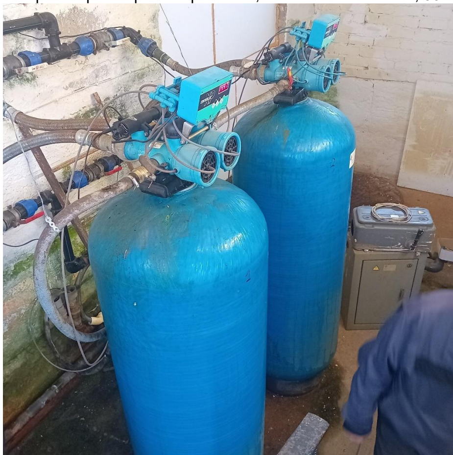
Joonis 5-13 Sihva (Voki) puurkaevpumpla sisevaade (paarisfilter)
