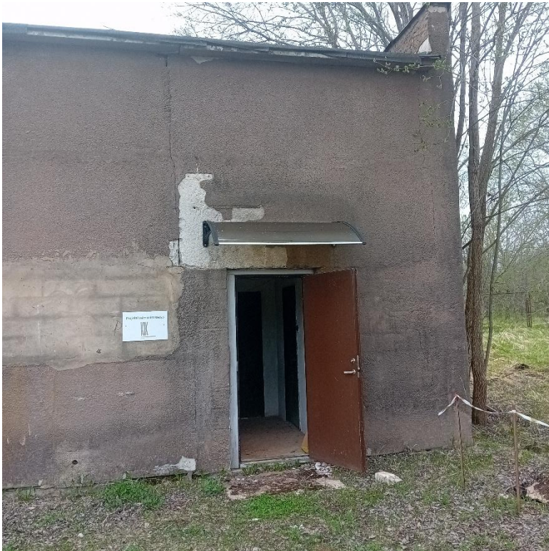
Joonis 5-9 Sangaste puurkaevpumpla hoone välisilme
