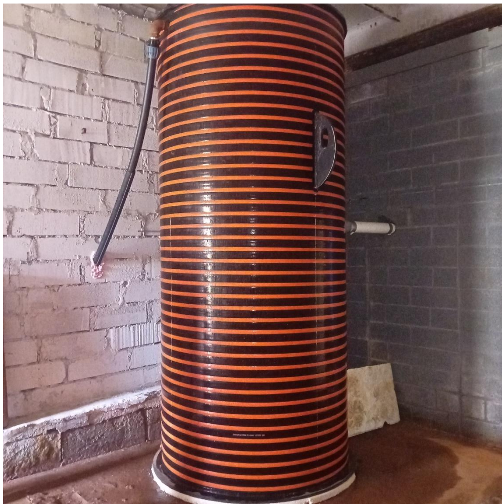
Joonis 5-12 Keeni Keskuse puurkaevpumpla uus puhtaveereservuaar
