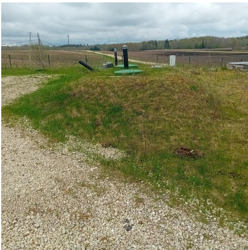
Joonis 6-7 Puka reoveepuhasti välisilme (protsessimahutid asuvad maa all)
