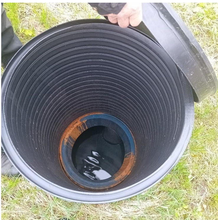
Joonis 6-13 Sihva reoveepuhasti pumbaga järelsetiti
