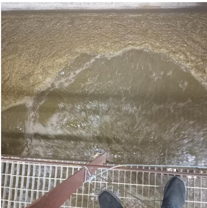
Joonis 6-5 Otepää alajaama reoveepuhasti aerotank
