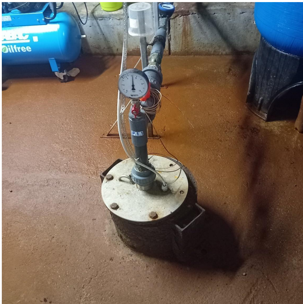
Joonis 5-11 Keeni Keskuse puurkaevpumpla sisevaade. Puurkaevu päis
